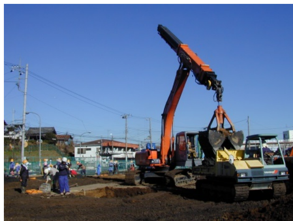
パイプクラムシェル作業状況
